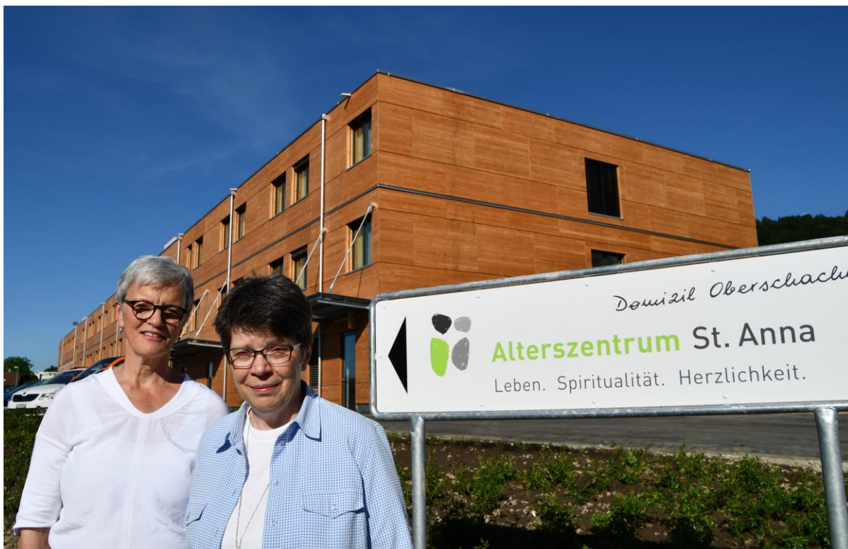
Grösstes, je in der Schweiz realisiertes Alterszentrum in Modulbauweise: Bernadette Schaller (links), Geschäftsleiterin St. Anna Stiftung, und Generaloberin Schwester Heidi Kälin vor dem Domizil Oberschache (Foto Daniel Deicher)
